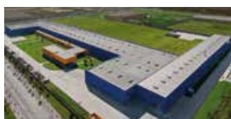
Hörmann Tianjin, Kína
